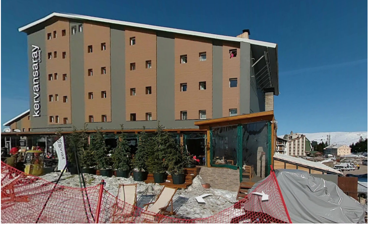
Binanın Yangın Öncesi Durumu
