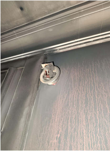
Kullanma Suyuna Bağlanmış Sprink Başlığı ve Kazan Dairesi
